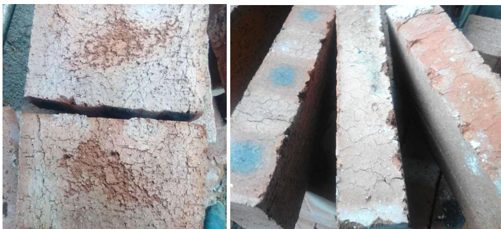
贵州某地页岩中蒙脱石矿物含量过高导致的废品
